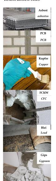
Eine vor Abbrucharbeiten durchgeführte Schadstofferkundung hilft kontaminierte Bauteile zu identifizieren und gezielt auszubauen. Durch einen verwertungsorientierten Rückbau wird die Qualität der mineralischen Fraktion erhöht. Bis zu 25 % der Entsorgungskosten bei Gebäudeabbrüchen können durch optimierte Sammelund Verwertungssystem eingespart werden (vgl. LIFE-Projekt RUMBA).
