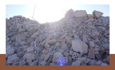
Ein verpflichtendes Abfallwirtschaftskonzept für die Baustelle sowie die Schadstofferkundung vor den Abbrucharbeiten stellen sicher, dass Schadstoffe aus dem Recyclingmaterial fernhalten werden. Der in Projekt EnBa entwickelte Schadstoffkatalog dient zur Identifikation und Entsorgung dieser Stoffe. Höhere Kosten für den größeren Arbeits- und Zeitaufwand werden durch vermiedene Deponierungskosten und Erlöse aus der Produktion von RC-Baustoffen ausgeglichen.
